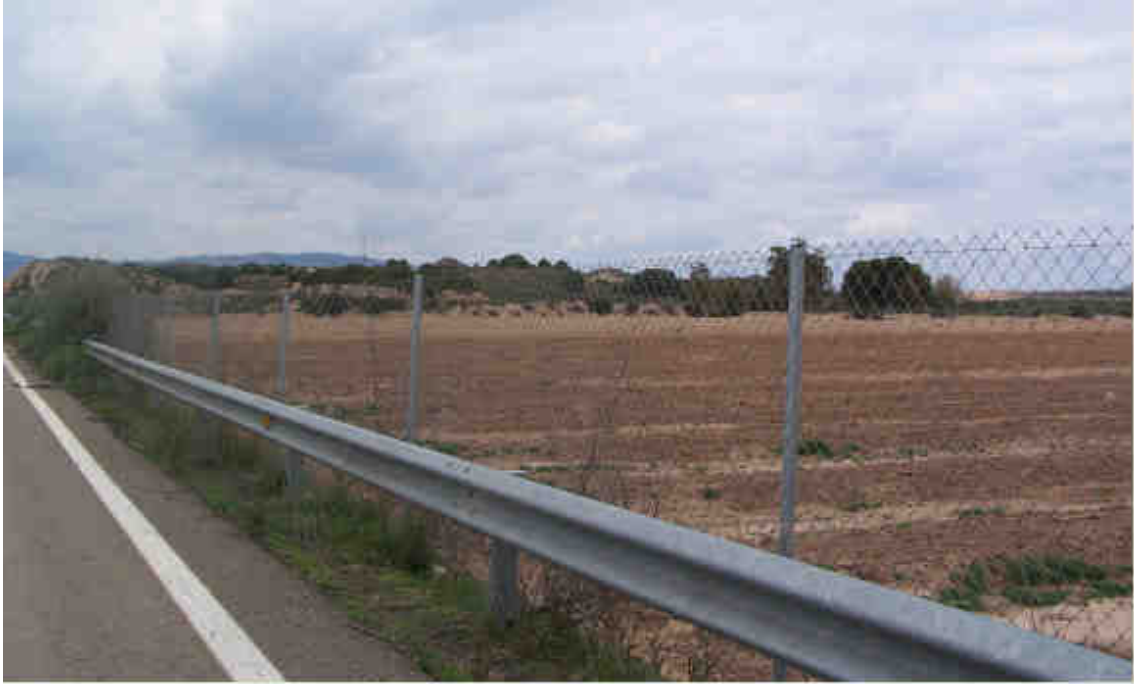
Imagen 5. Vistas desde la antigua carretera de Fuente Álamo (actual vía de servicio).
