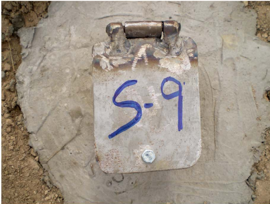
PIEZÓMETRO EN EL SONDEO S-9
