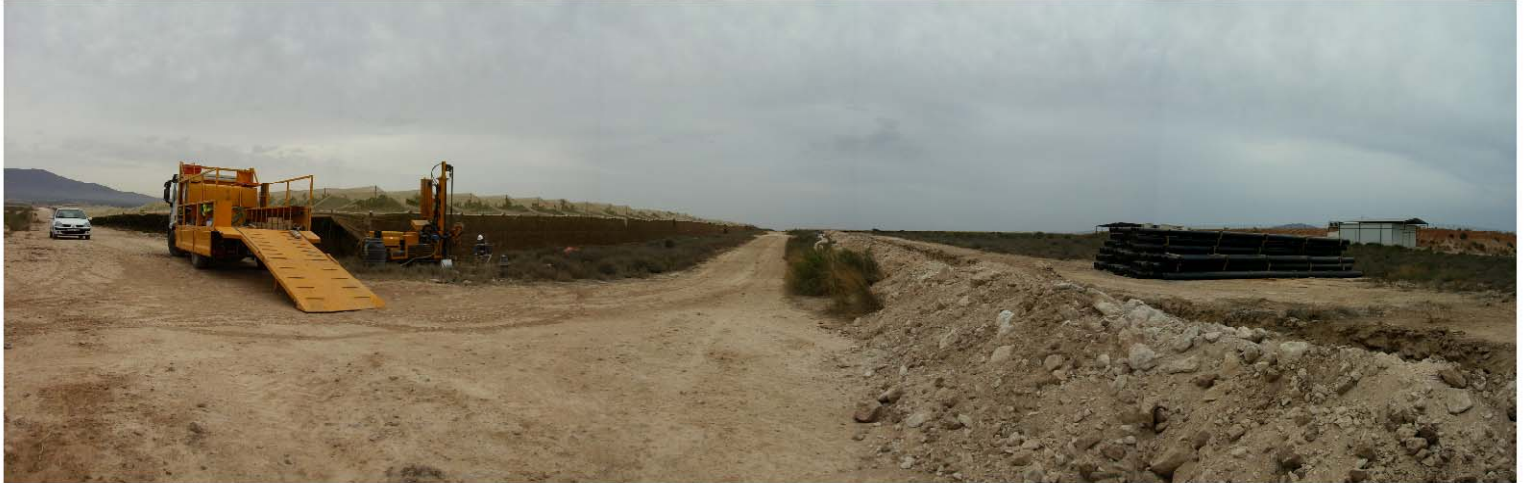
EMPLAZAMIENTO DE LA MÁQUINA EN EL SONDEO S-9
