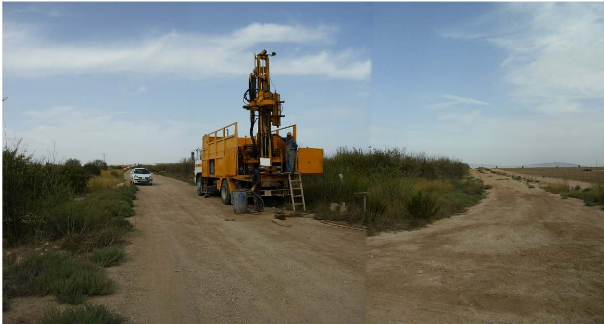
EMPLAZAMIENTO DE LA MÁQUINA EN EL SONDEO S-8
