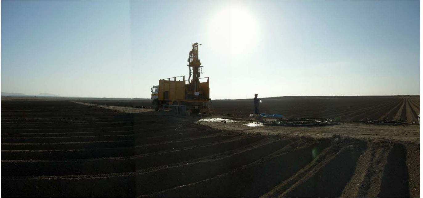
EMPLAZAMIENTO DE LA MÁQUINA EN EL SONDEO S-6
