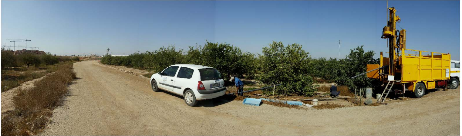
EMPLAZAMIENTO DE LA MÁQUINA EN EL SONDEO S-4
