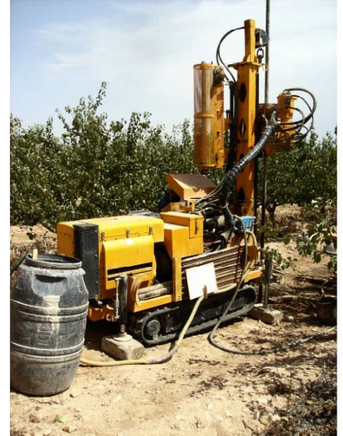
EMPLAZAMIENTO DE LA MÁQUINA EN EL SONDEO S-11
